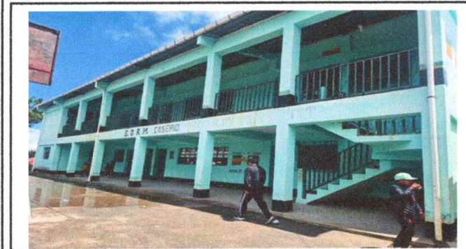
Foto 3: mantenimiento de barandas, lijado, cepillado y pintado.
