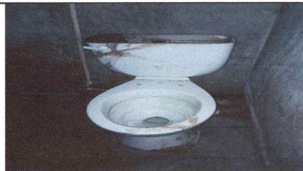
Foto 10: Sustitución de Inodoro aldosa de botón.
