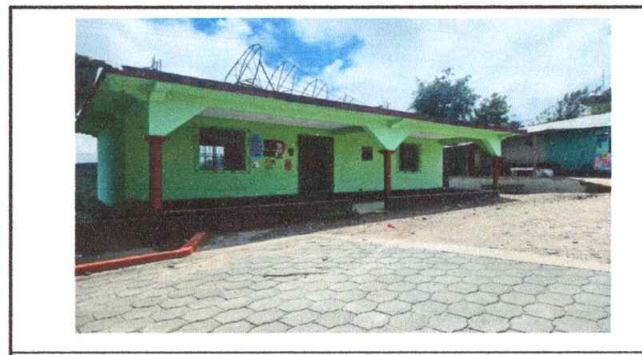
Foto 6: Pintura comex en muros exteriores e interiores.
