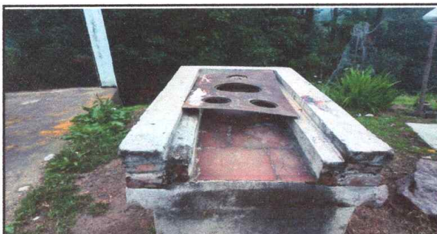
Foto 11: Sustitución de estufa rural.
