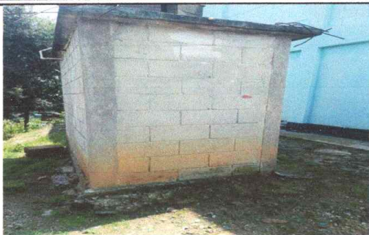
Foto 7: Sustitución de llave de paso y reparación de plancha de concreto de patio.
