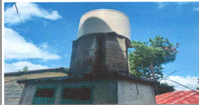
Foto 5: Fabricación e instalación de estructura portante de metal para depósito.
