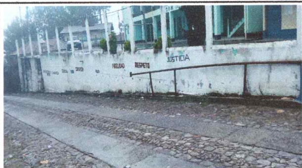
Foto 13: Pintura comex en muros exteriores.
