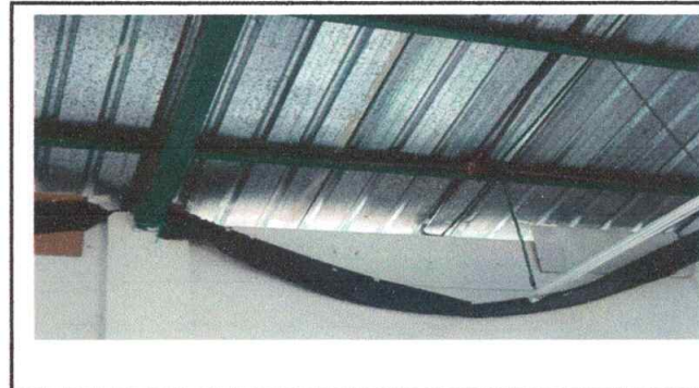
Foto 4: Sellado de grietas y aberturas sobre muros.
